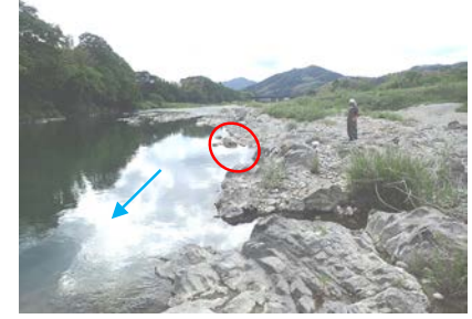
岩盤露出部の河道状況 (15.6k左岸)
