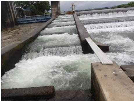
隔壁水深=15cm、隔壁流速=1.2m/s
