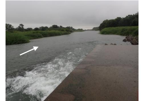
堰越流水が水叩きから折り返しプールに流入し、下流側魚道の流量が増加
