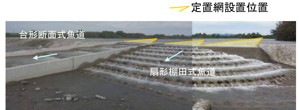
図-2 新屋敷取水堰の新設魚道の様子 H29.5.3(濁水傾向)撮影
