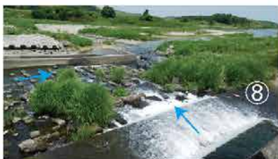
⑧ 用水余水放流口と右岸側護床工の全景
