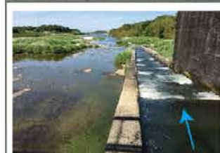
右岸魚道全景
