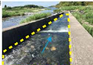
⑧ 用水余水放流口と右岸側護床工の全景
