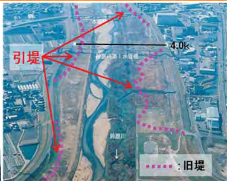
鈴鹿川3.0k付近の状況
