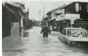
昭和49年7月洪水 浸水状況 (鈴鹿市庄野町)
