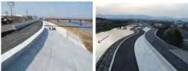
高潮堤整備状況(鈴鹿川右岸1.0k付近)
