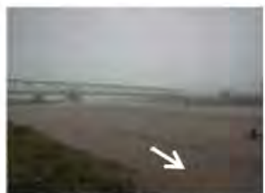
平成24年9月洪水 出水状況 (内部川 河原田観測所)
