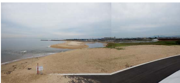
鈴鹿川派川河口部の状況
