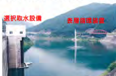
選択取水設備と表層循環装置 選択取水設備は、貯水池にたまった表面のきれいな水を選択して取水する設備。 表層循環装置は、淡水赤潮の原因となる植物プランクトンの発生しにくい環境をつくる
