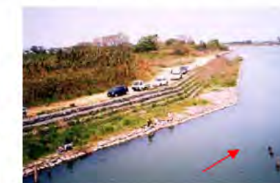
東黒部頭首工湛水域は釣り等の親水の場となっている。(4.0k付近左岸)
