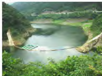
流入水制御フェンス 貯水池の表層水と放流水を清澄に保つ。発生した淡水赤潮や出水時の濁水をフェンス上流部に隔離する。
