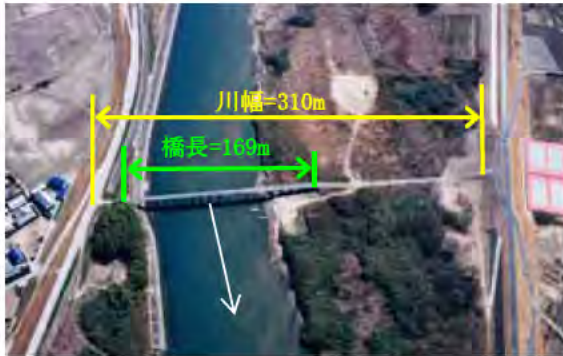
川幅に比べ橋長が短く、左岸橋台は高水敷に設置されている。
