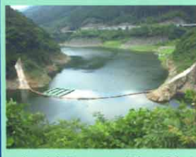
流入水制御フェンス(緑色の浮島は人工生態礁)
