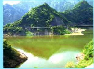
貯水池内における淡水赤潮発生状況(すじ状に分布している)
