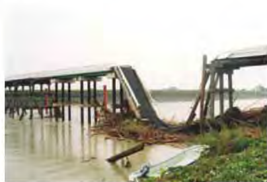
平成9年7月洪水において橋脚にゴミ、流草木が集積し落橋した。
