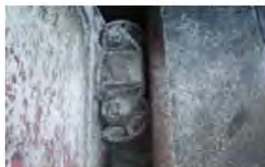
写真 2-1-6 ローラーゲート (ローラーが腐食により回転不能となっている。)
