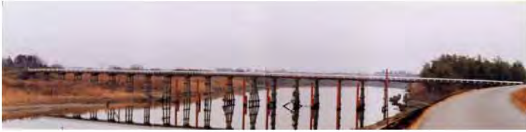
橋脚が多く径間が短い木橋である。
