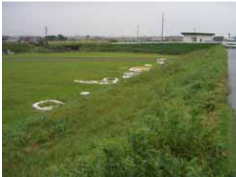
写真 1-1-12 平成 16 年 9 月洪水 魚見橋上流左岸 4.6k 付近のガマ発生状況
