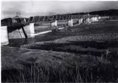
写真 1-1-10 昭和 34 年 9 月洪水 【提供：大西春海氏】 榎田川頭首工 ( 現榎田可動堰 ) の出水後の 状況 ( 手前から 2 本目の橋脚に上流紀勢線橋梁か ら流出した桁が見られる。 )
