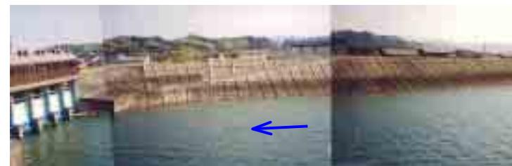
右岸 10. 6k 付近 (高水・低水護岸)
