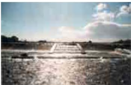
東黒部頭首工の魚道
