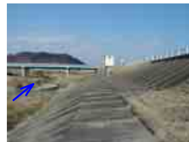
右岸 0.6k 付近 (高水・低水護岸)
