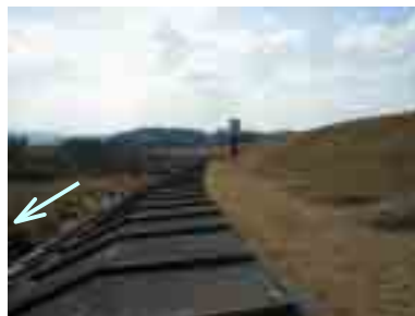
左岸 1.0k 付近 (低水護岸)
