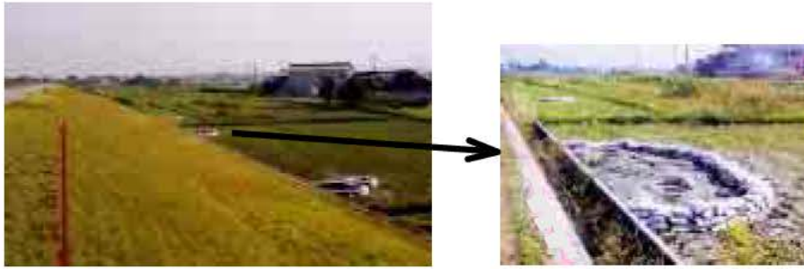
漏水の状況 (2.6k 付近左岸)
