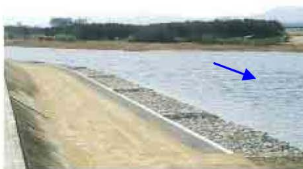
松名瀬地区耐震対策
