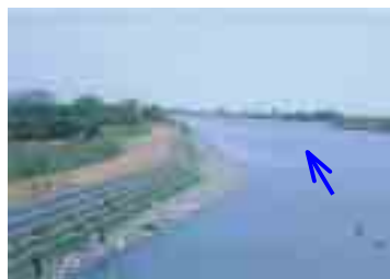
左岸 4. 2k 付近 (低水護岸)
