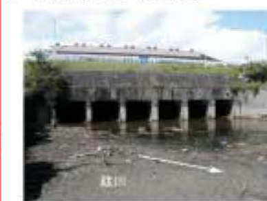
本川洪水時の被川水門下流の状況
