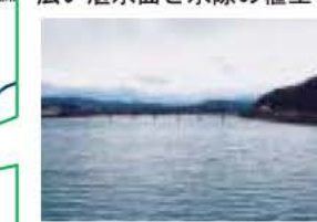
榊田可動堰の湛水面
