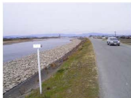
写真4-2-2 整備必要区間の現状
