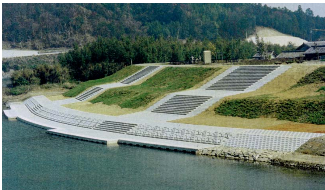
写真 4-2-4 階段の整備状況（佐奈川 0k 付近）
