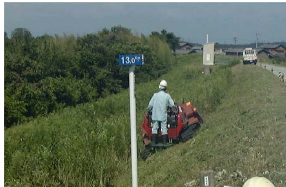
写真 4-3-3 堤防除草 (13k 付近)
