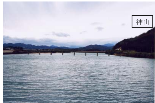
写真 4-3-18 櫛田可動堰の湛水面
