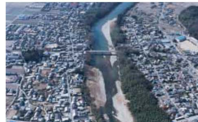
櫛田川本川下流 (両郡橋付近) 河畔林が連続し、沿川には家屋が密集しています。
