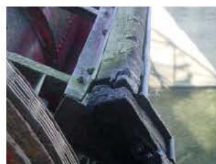
写真 2-1-7 ローリングゲート (木製戸当たりが腐敗している。)
