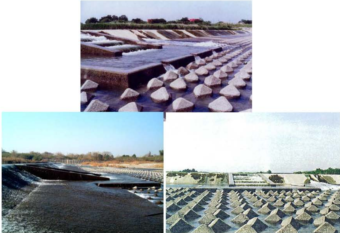
写真2-1-19 遡上機能が不十分な東黒部頭首工の魚道
