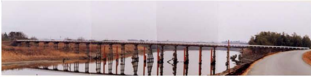
橋脚が多く径間が短い木橋である。
