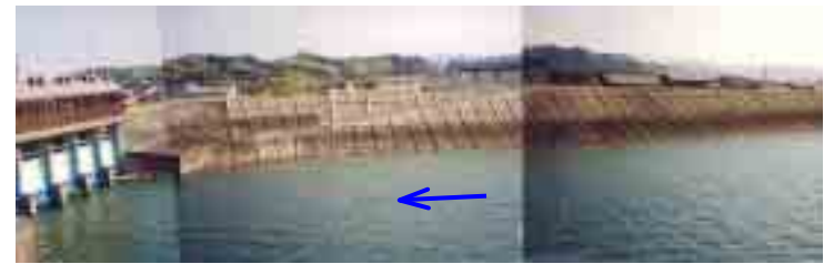
右岸 10.6k 付近(高水・低水護岸)
