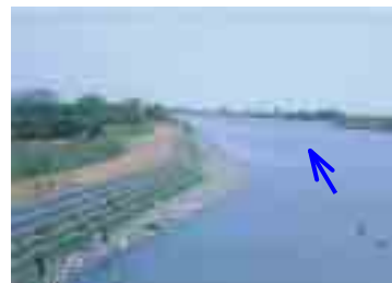
左岸 4.2k 付近(低水護岸)
