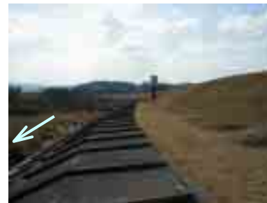
左岸 1.0k 付近 (低水護岸)
