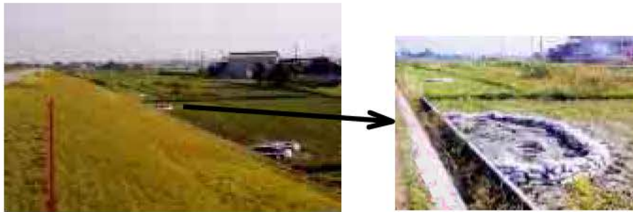
漏水の状況 (2.6k 付近左岸)
