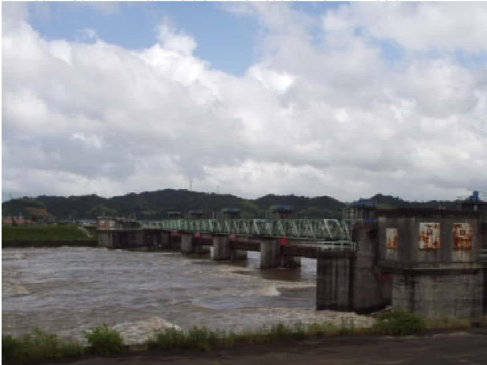
櫛田可動堰 ゲート全開状況 (台風4号) H15.5.31
