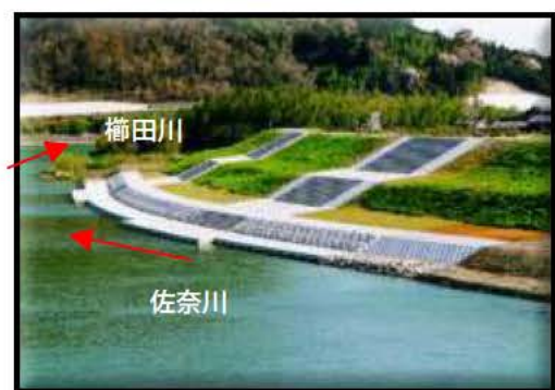
櫛田川合流部 (船着き場を兼ねた護岸)
