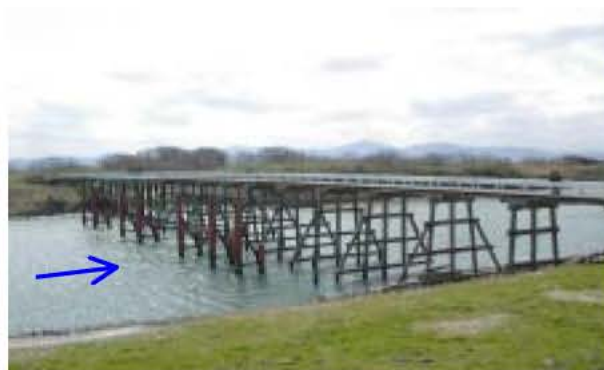
大平橋による流下阻害
