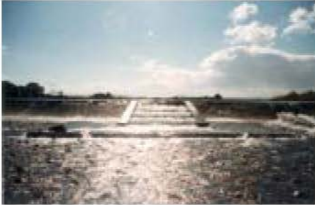
東黒部頭首工の魚道
