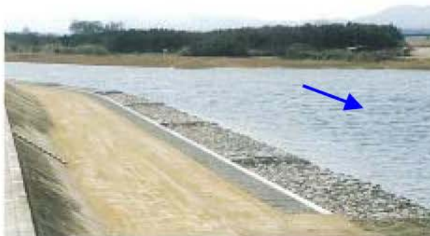
松名瀬地区耐震対策
