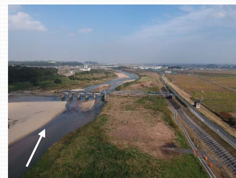
樹木伐採(完了後)
