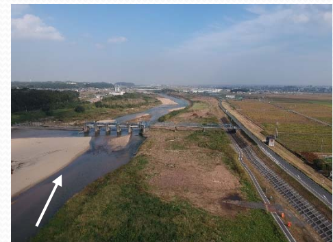
樹木伐採(完了後)
