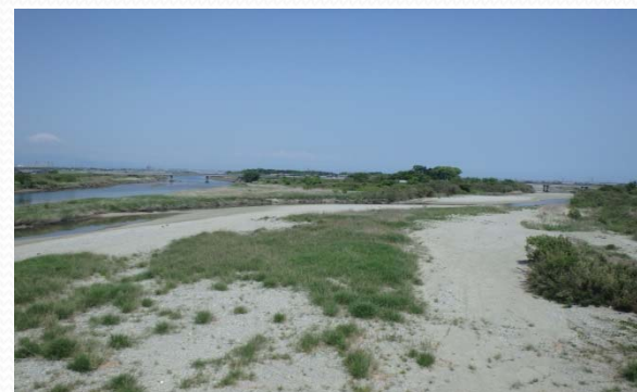
河道内の変状把握(堆積・洗堀等)
