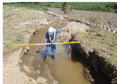
被災状況確認
