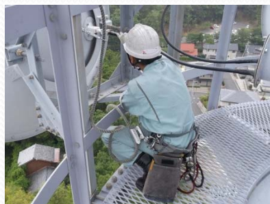
通信設備点検
