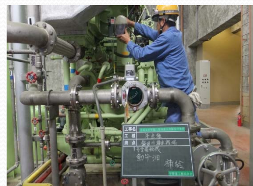
機械設備点検
