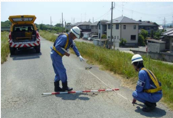
堤防や護岸の変状把握
