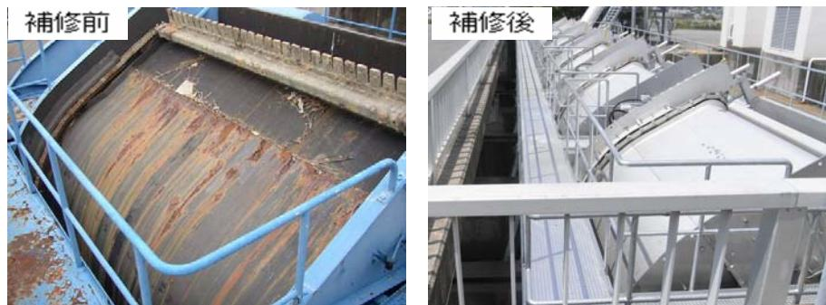
図 2-6 勢田川排水機場の補修（勢田川0.7K）
