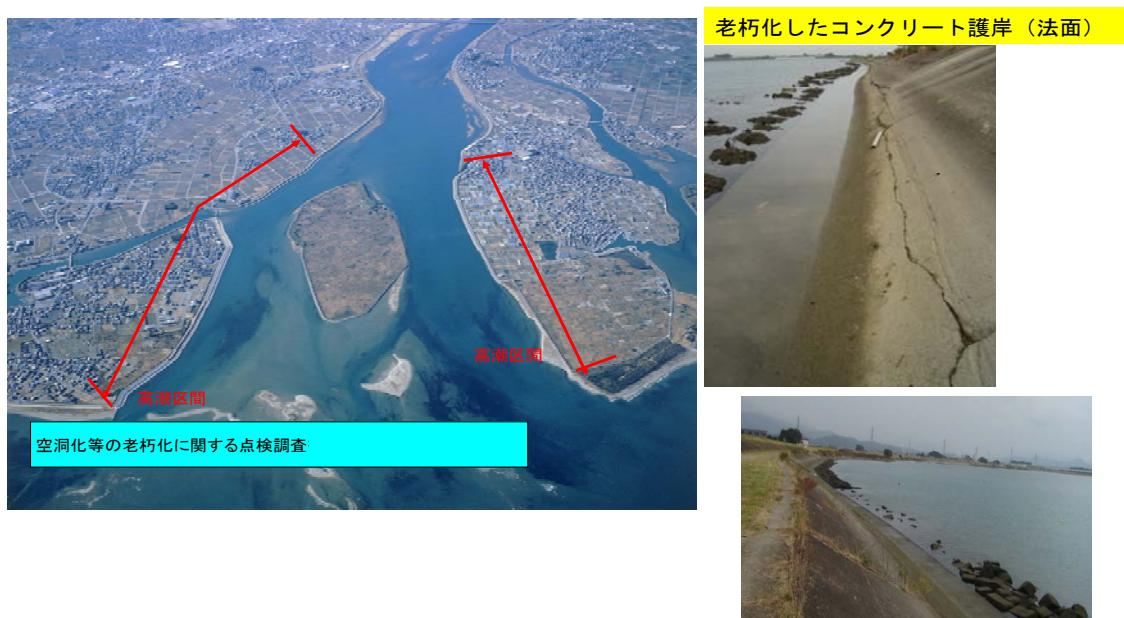
図 2-5 高潮堤防の老朽化
