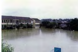
明倫小学校の冠水状況
