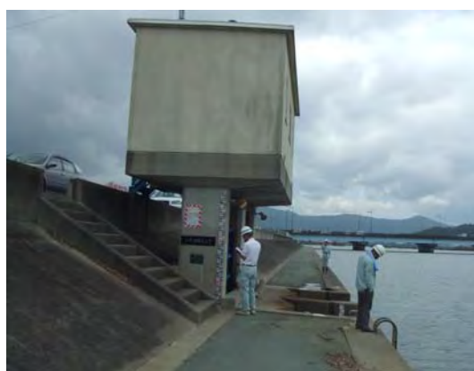
図 2-7 西新田排水樋管点検状況（五十鈴川右岸2.8k付近）
