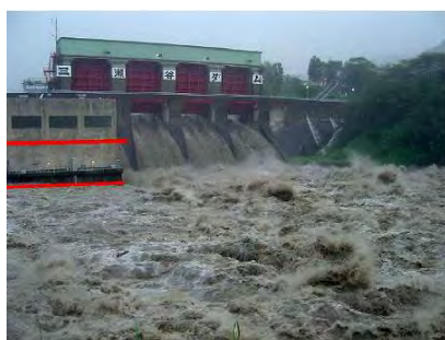
三瀬谷ダムの放流状況
