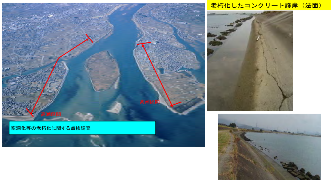
図 2-5 高潮堤防の老朽化
