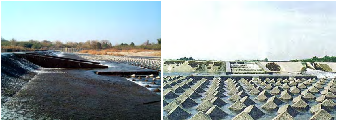
図 2-21 遡上機能が不十分な東黒部頭首工の魚道
