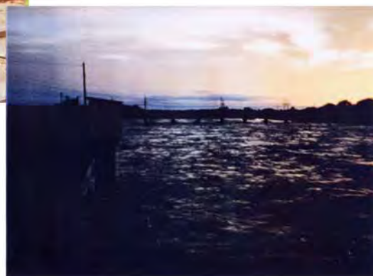
洪水時の状況 (7.8k 付近)
