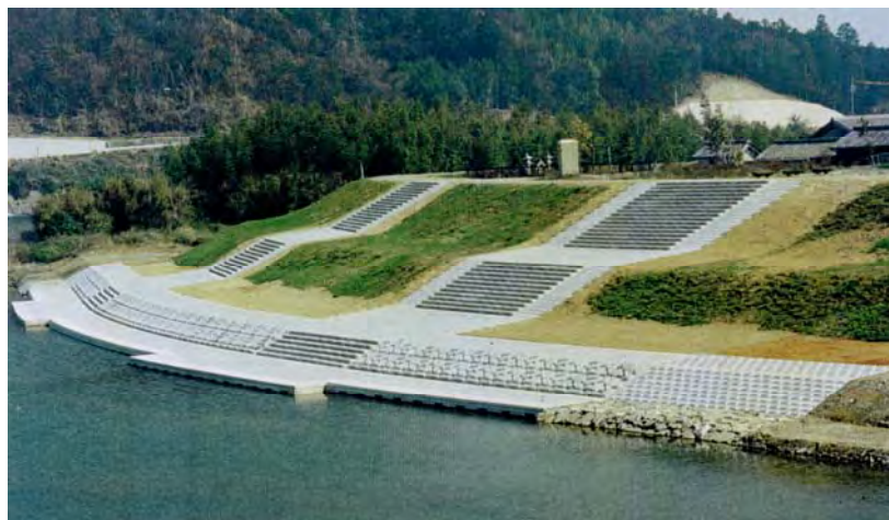
図 2-17 階段の整備状況(佐奈川0k付近)
