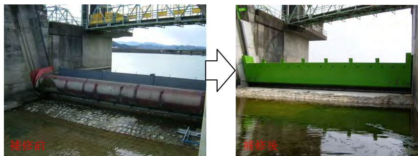
図 2-9 櫛田可動堰ゲートの補修状況
