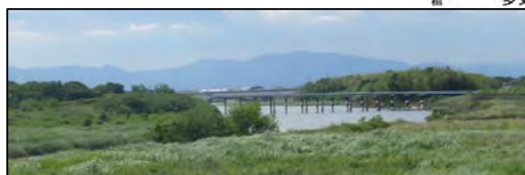
橋脚が多く径間が短い木橋である (大平橋を上流より望む)
