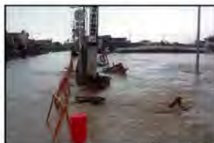
昭和57年8月洪水 溢水状況 (勢田川右岸5.8k付近)
