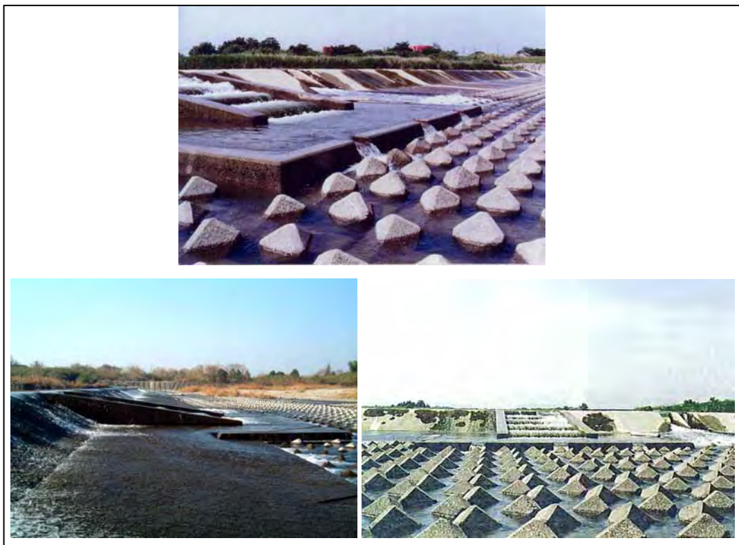
遡上機能が不十分な東黒部頭首工の魚道
