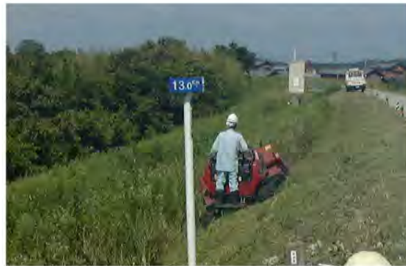
写真 4-3-3 堤防除草 (13k 付近)
