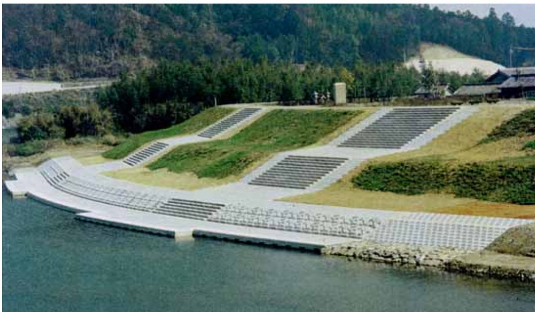
写真 4-2-4 階段の整備状況（佐奈川合流点(0k)付近）
