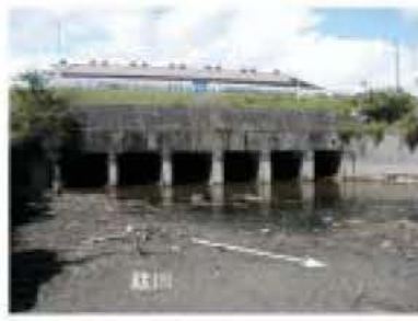
本川洪水時の被川水門下流の状況
