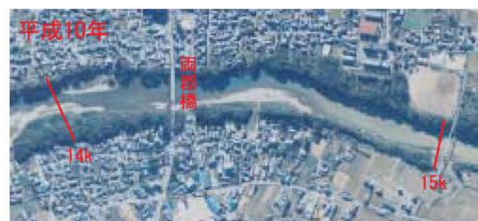
樹木群の拡大の状況 (両郡橋付近)
