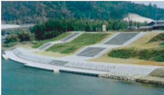
階段護岸の整備状況（佐奈川0k付近）
