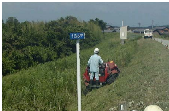
写真 4-3-3 堤防除草 (13k 付近)
