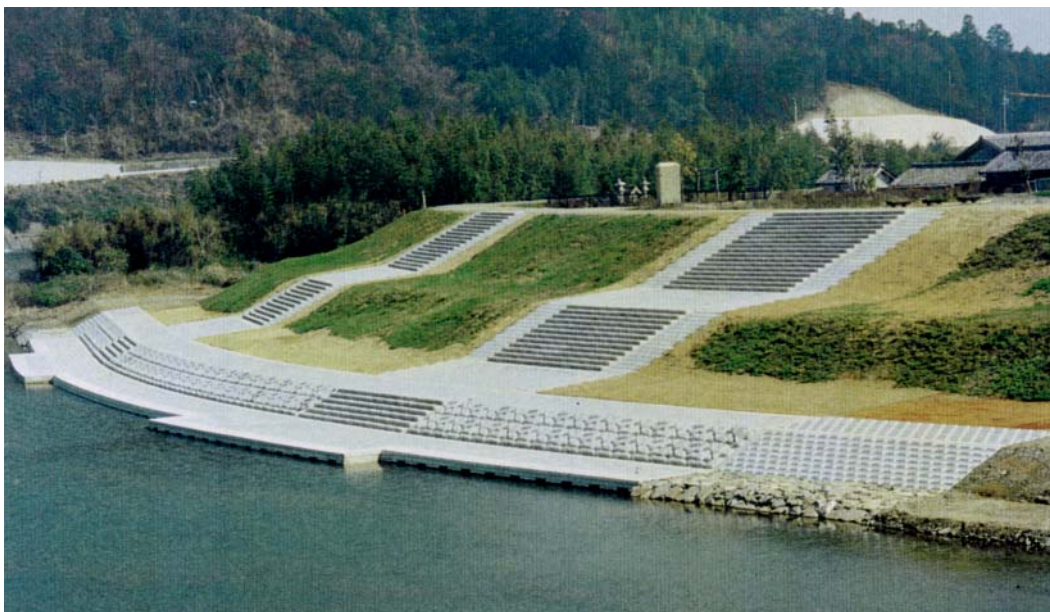
写真 4-2-4 階段の整備状況（佐奈川 0k 付近）
