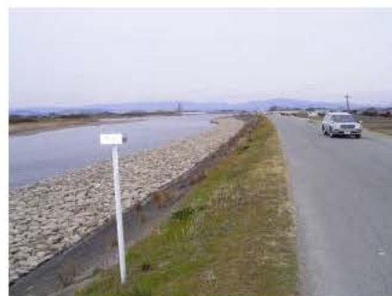
写真4-2-2 整備必要区間の現状
