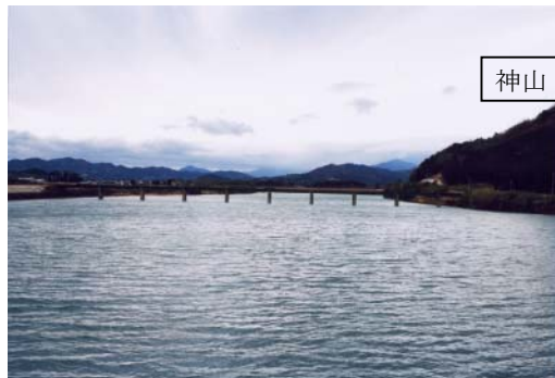
写真 4-3-18 榎田可動堰の湛水面
