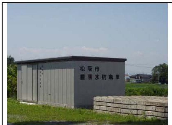
写真 4-3-5 水防倉庫 (豊原：松阪市)
