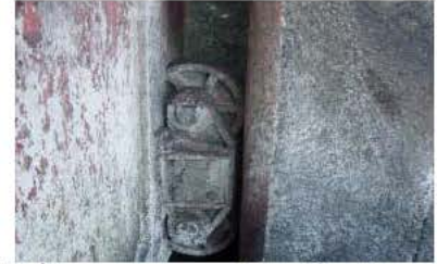
写真 2-1-6 ローラーゲート (ローラーが腐食により回転不能となっている。)
