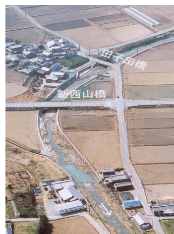
写真 2-1-3 佐奈川上流背後地 (4.5k 付近) 背後の宅地地盤は高くなっている
