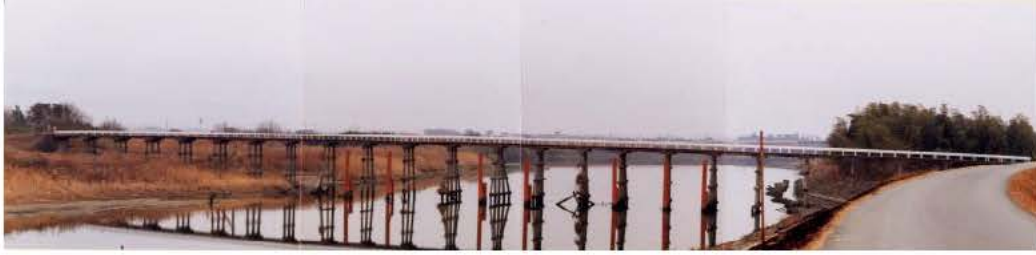
橋脚が多く径間が短い木橋である。
