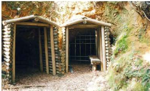
写真 1-1-7 丹生の水銀鉱山跡〔出展：街道物語（津地区・松阪地区広域行政事務組合）〕 丹生の水銀は、奈良時代に発見された日本最古の水銀であり、射和輕粉の原料に利用された。
