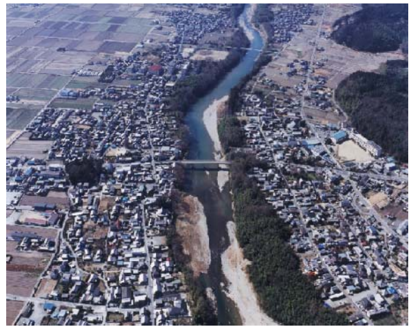
写真 1-1-4 櫛田川本川下流 (両郡橋付近) 河川沿いに家屋が密集し樹木群が繁茂している。
