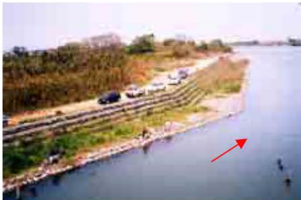
東黒部頭首工湛水域での釣り（4.0k 付近左岸）
