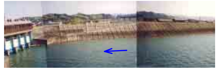
右岸 10.6k 付近 (高水・低水護岸)
