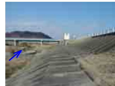
右岸 0.6k 付近 (高水・低水護岸)
