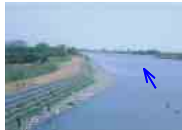
左岸 4.2k 付近 (低水護岸)
