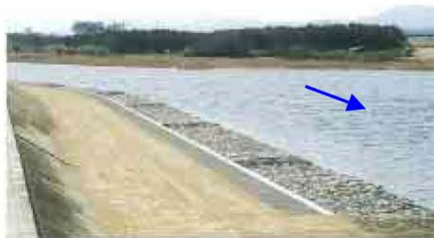
松名瀬地区耐震対策
