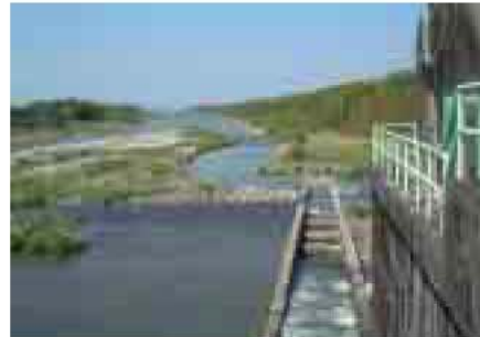
櫛田可動堰の魚道
