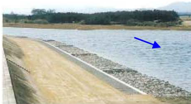
松名瀬地区耐震対策
