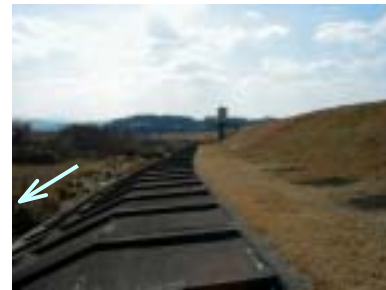
左岸 1.0k 付近 (低水護岸)
