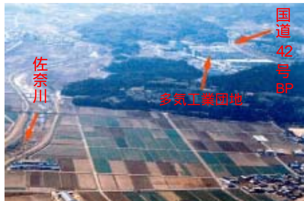
多気工業団地全景
