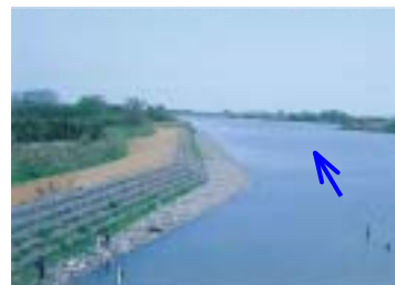
左岸 4.2k 付近 (低水護岸)
