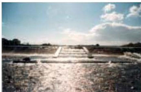
東黒部頭首工の魚道
