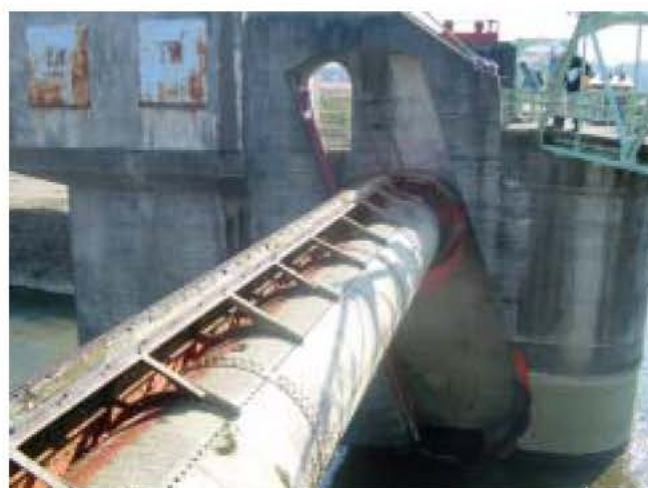
全体的に腐食が進んでいる (写真：昭和29年製作ローリングゲート)
