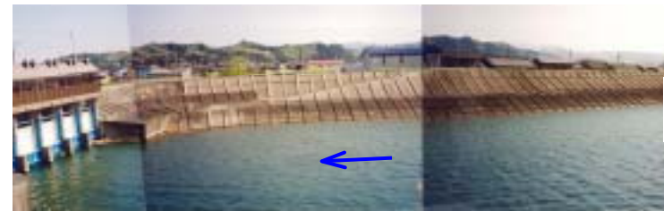
右岸 10.6k 付近 (高水・低水護岸)
