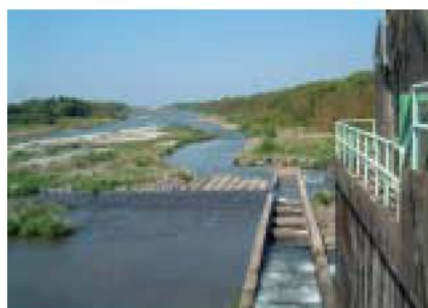
櫛田可動堰の魚道
