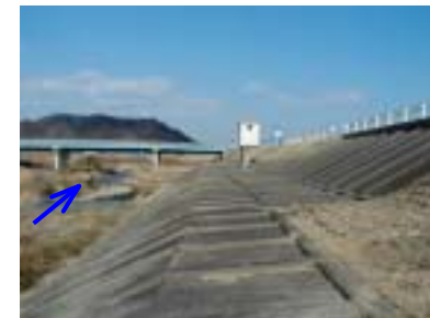
右岸 0.6k 付近 (高水・低水護岸)
