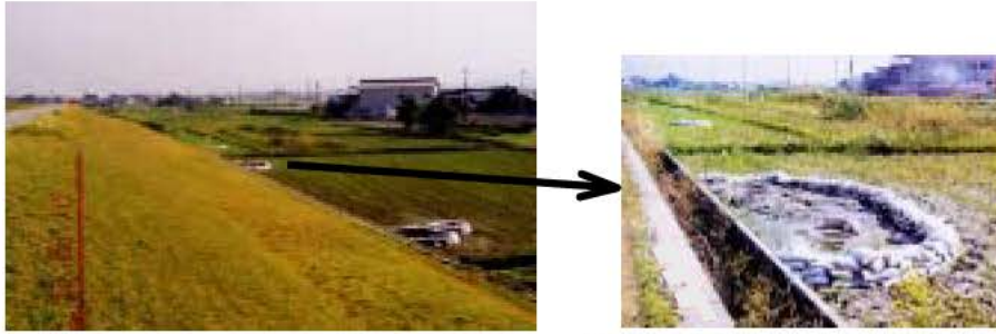
漏水の状況 (2.6k 付近左岸)
