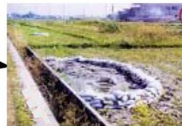
漏水の状況（2.6k 付近左岸）
