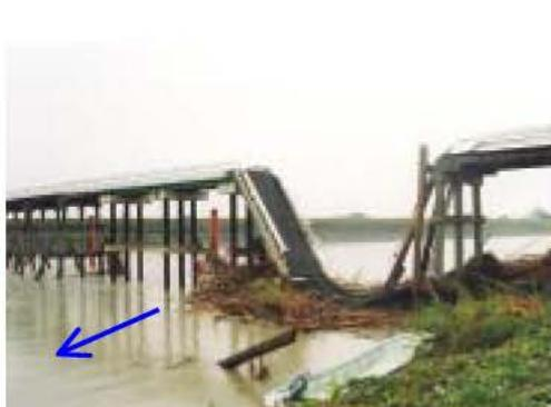
平成 9 年洪水により一部落橋(大平橋)
