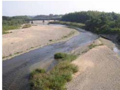
砂礫河原と河畔林（安楽川 1.0k 付近）
