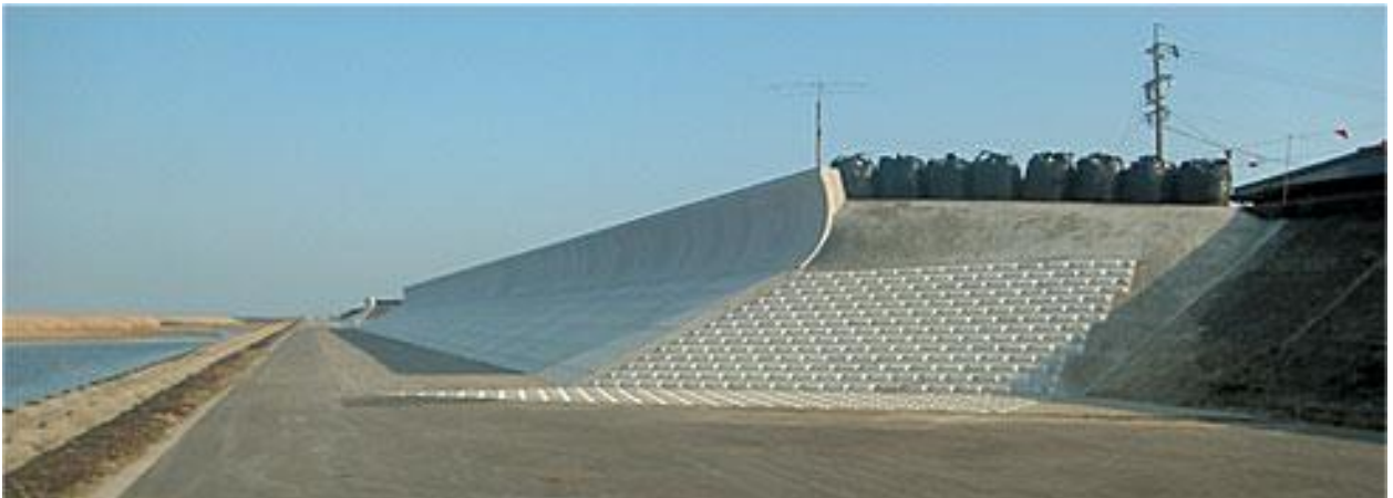
図 2-5 完成した高潮堤防
