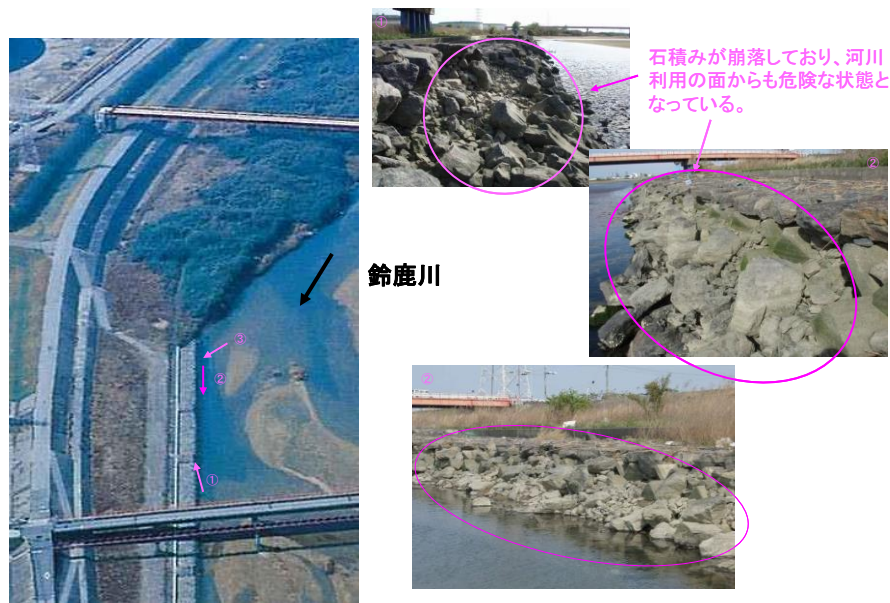
図 2-4 護岸の洗堀状況
