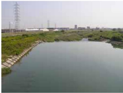
河原田用水堰の湛水域（内部川 2.6k 付近）
