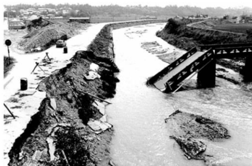
内部川 北小松橋流出状況
