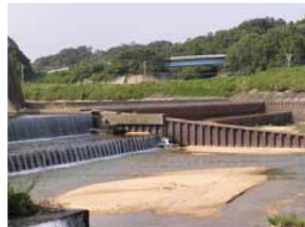
鈴鹿川第二頭首工魚道の状況
