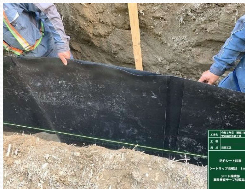
防根・防竹シートの敷設
