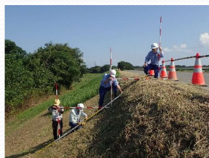
被災状況確認
