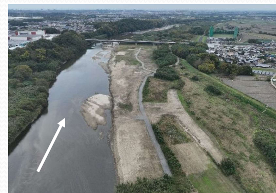
樹木伐採(完了後)
