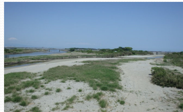
河道内の変状把握(堆積・洗堀等)
