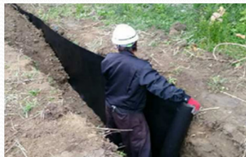
防草シートの敷設
