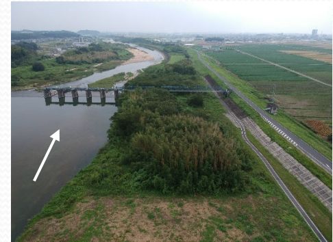
樹木伐採(着工前)
