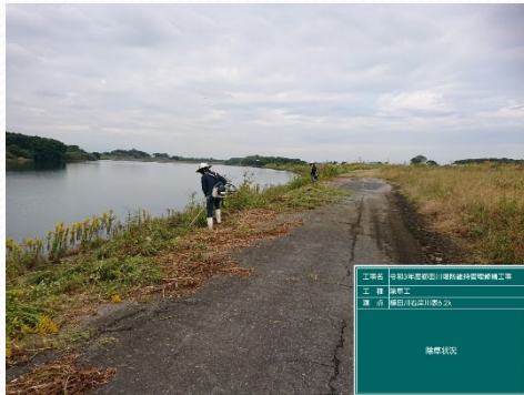
堤防除草状況(肩掛け式)
