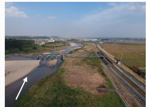
樹木伐採(完了後)
