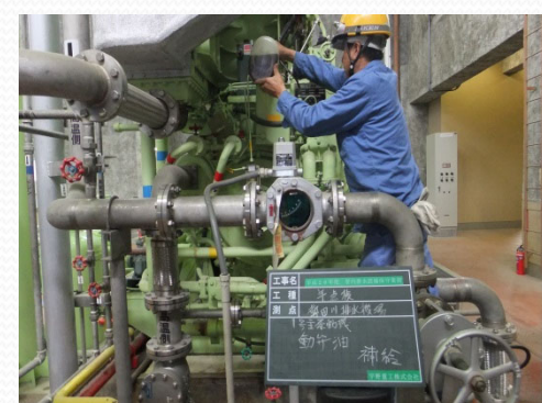
機械設備点検
