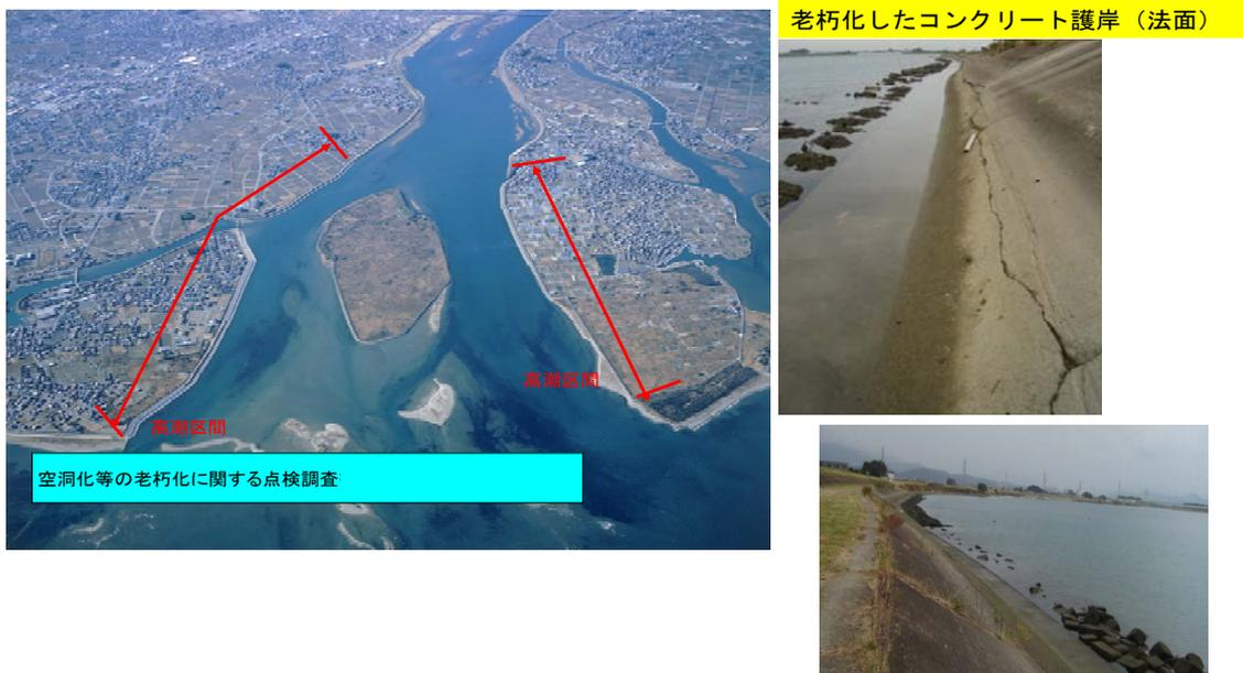
図 2-5 高潮堤防の老朽化
