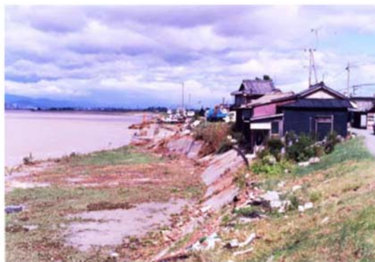
図 1-10 松名瀬地区(1.8k 付近)
