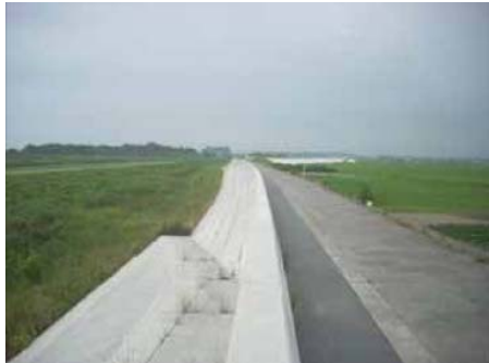
図 2-5 整備後の高潮堤防
