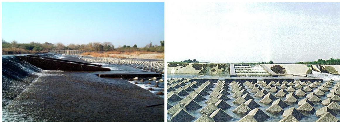
図 2-19 遡上機能が不十分な東黒部頭首工の魚道
