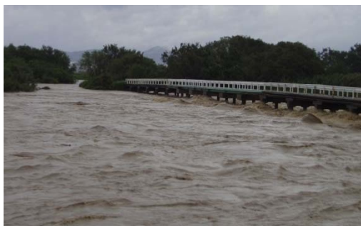
図 1-12 平成 16 年 9 月大平橋付近の状況写真
