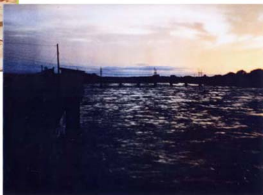
洪水時の状況 (7.8k 付近)
