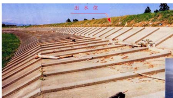
過去最高水位の櫛田川下流 (3.4k 付近) 平成 6 年 9 月洪水
