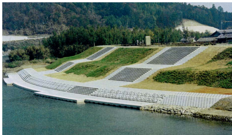
図 2-15 階段の整備状況 (佐奈川 0k 付近)
