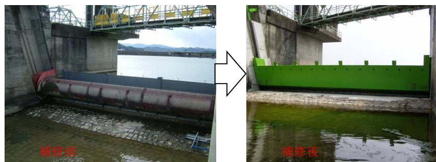
図 2-9 櫛田可動堰ゲートの補修状況
