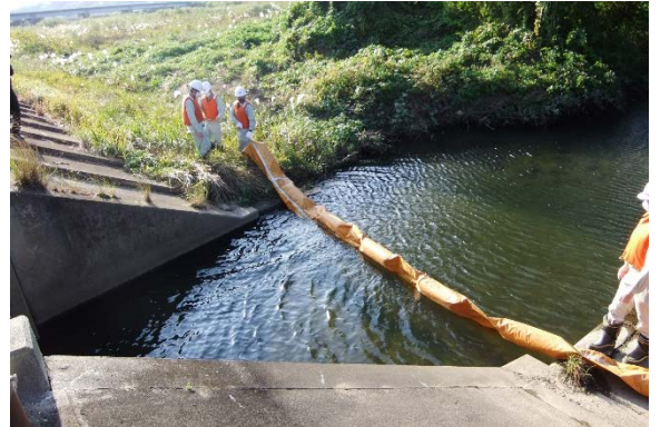
吸着マットの設置、撤去
