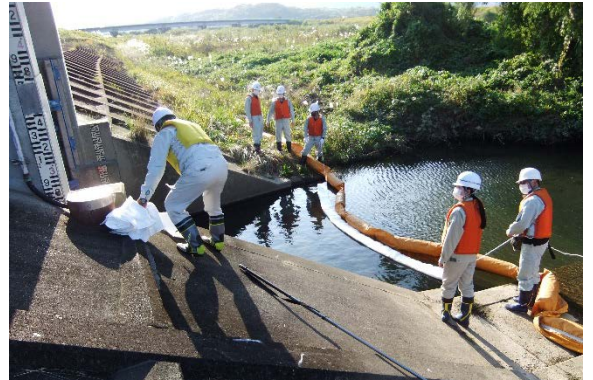
吸着マットの設置、撤去
