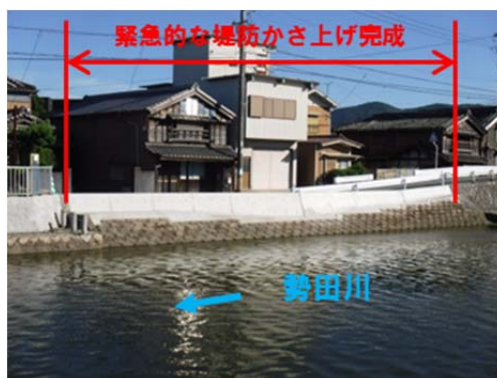
図 2-2 特殊堤防設置状況（北新橋右岸下流）
