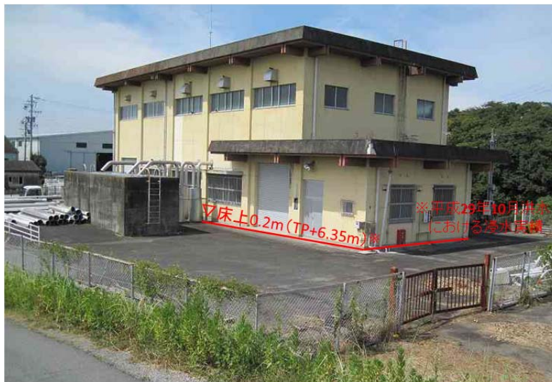
図 4-3 汁谷川排水機場
