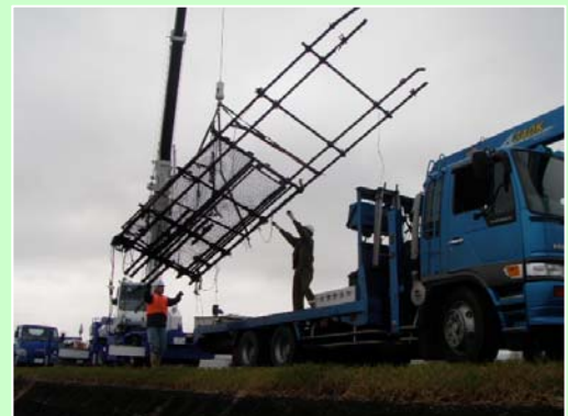
棧橋の撤去②
