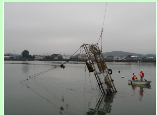
棧橋の撤去①
