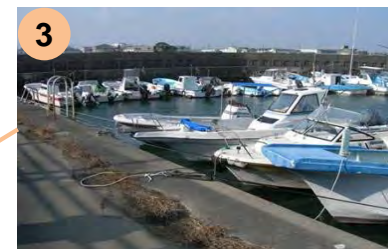
3 一色町地先船溜まり
