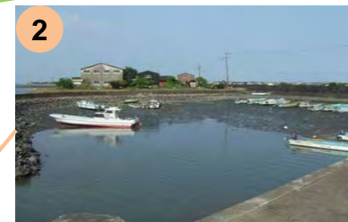
2 一色町物揚場施設
