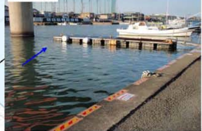
右岸0.6k付近(防潮水門下流船溜)
