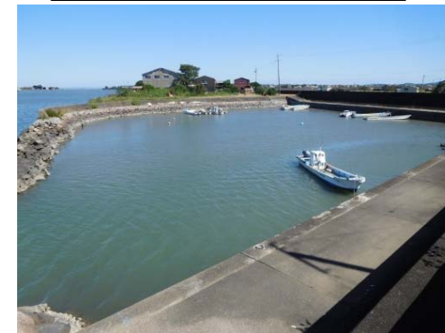
一色町物揚場施設
