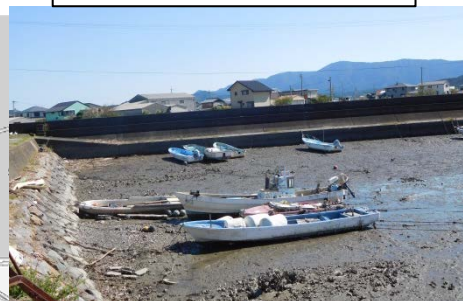
一色町物揚場施設
