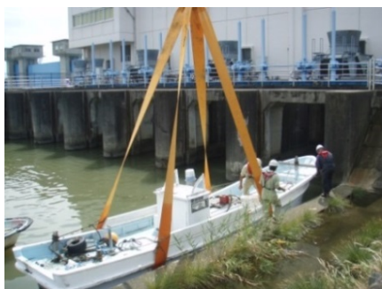
③撤去作業
