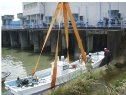
③撤去作業
