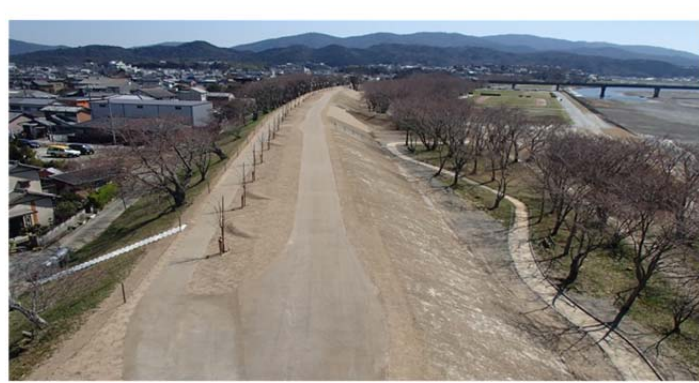
上流より下流を望む
