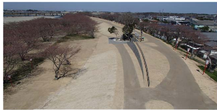
上流より下流を望む
