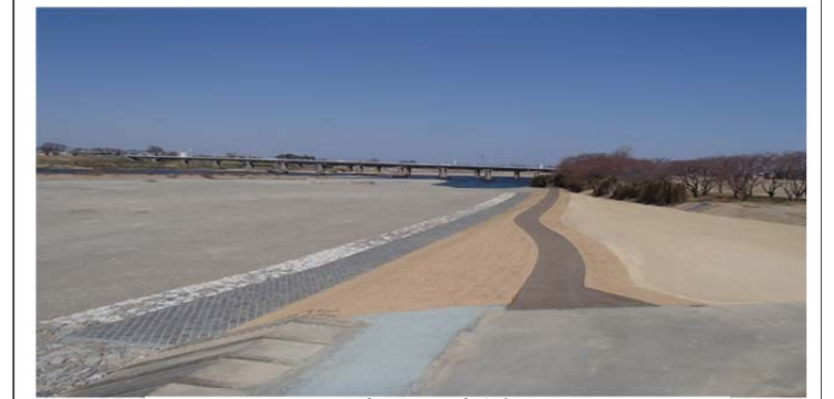
上流より下流を望む
