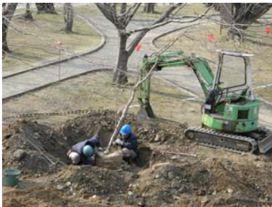
掘り取り作業の様子
