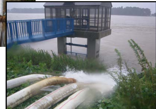
排水作業状況
