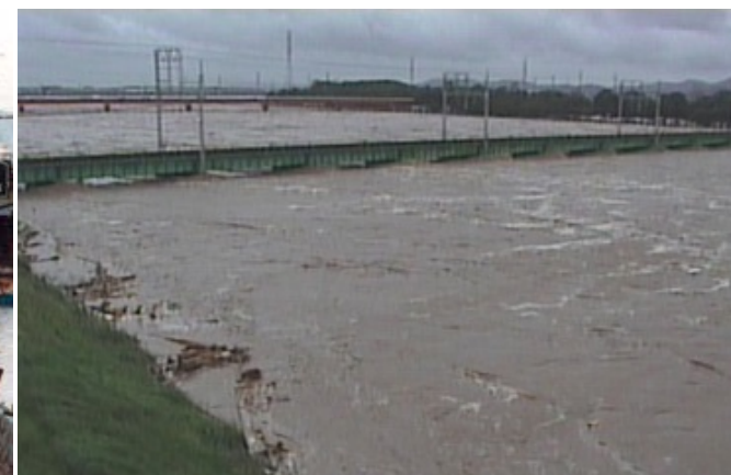
平成16年9月29日出水 宮川4.9k付近 近鉄宮川橋梁
