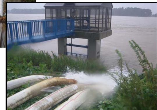
排水作業状況
